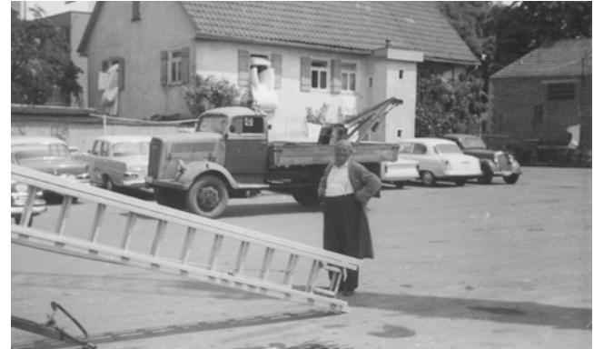
Die Nachfrage steigt: Die Werkstätten für Pkw- und Nfz platzen aus allen Nähten. Und auch die Kundenannahme entspricht nicht mehr den Anforderungen der neuen Zeit. Nur ein Neubau kann hier helfen!
